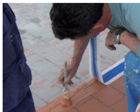
Impermeabilizzazione di un giunto di frazionamento con Mapeband fissato con Aquaflex Roof
