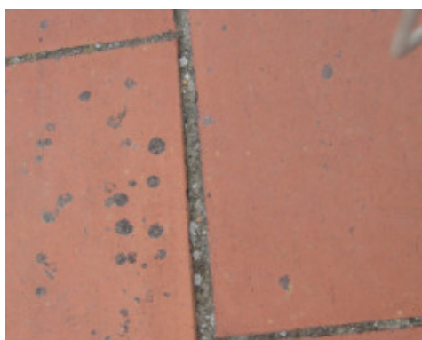
Pavimentazione esistente in cotto che necessita di preparazione prima della posa di Aquaflex Roof
